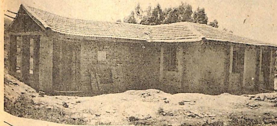
En el municipio cienfueguero de Cumanayagua, han construido viviendas, como la que aparece en la foto, utilizando bloques fabricados con suelo-cemento.
