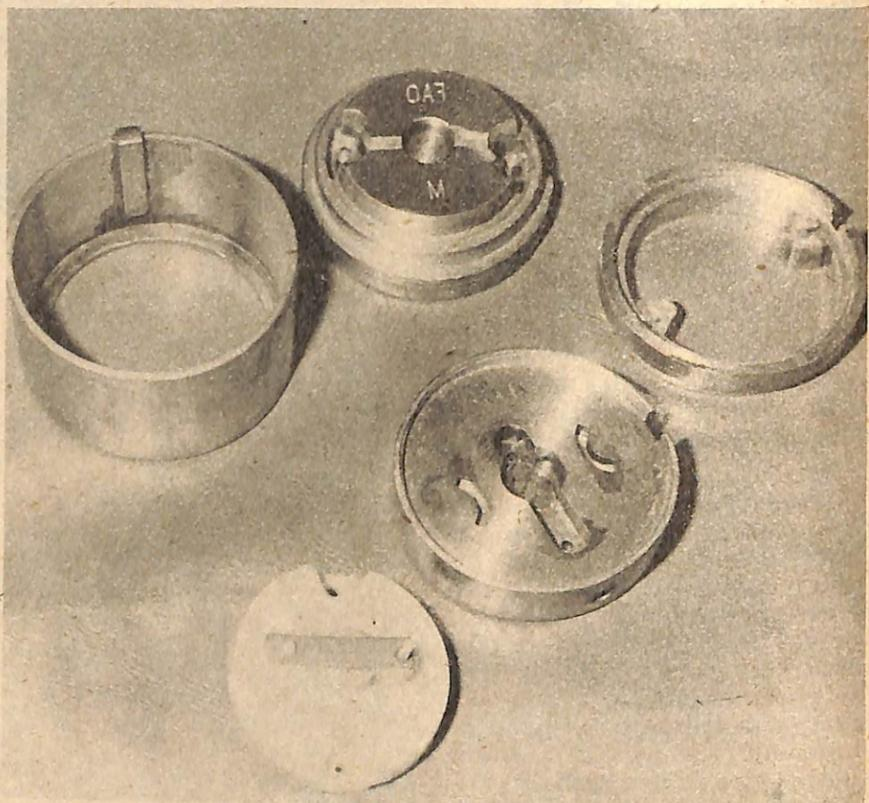
Troquel para confeccionar la articulación de una válvula (de goma) de control de la redistribución del aire de los frenos a la suspensión de los ómnibus IKARUS. Pinar del Río.
